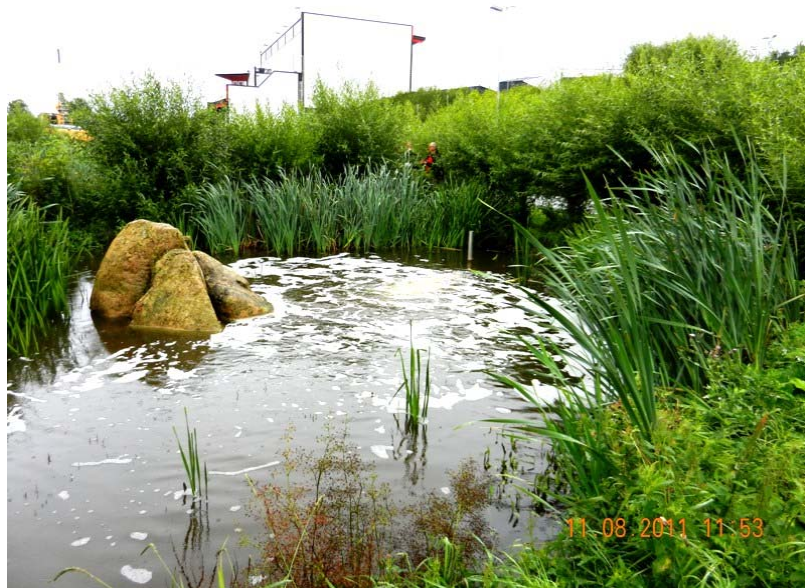
Figur 10. Sivbed med luftet dam (foto BB)
