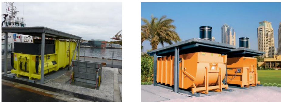
Figur 5: Nedgravde containere med komprimering (Foto: Stavanger kommune/ HABA Group Oy)
