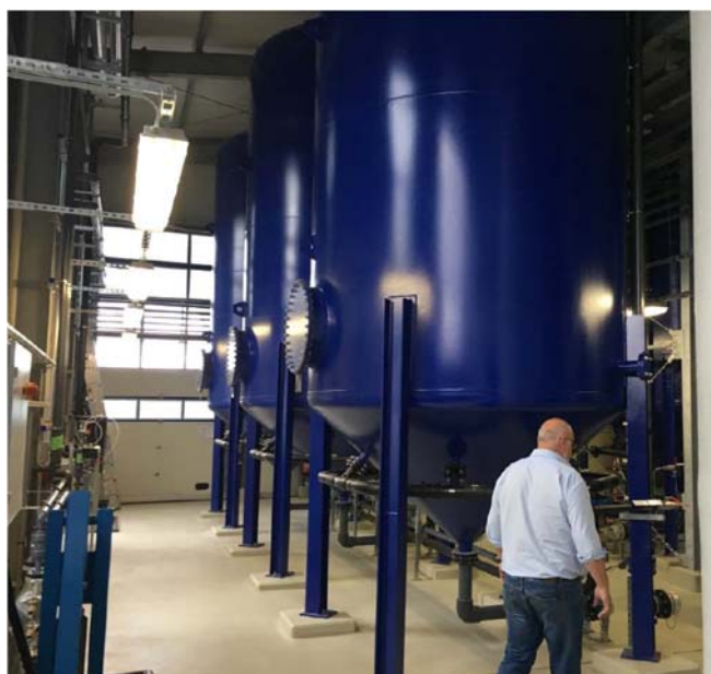
Figur 23. Aktivt kull kolonner for polering av sigevann (foto ROAF)
