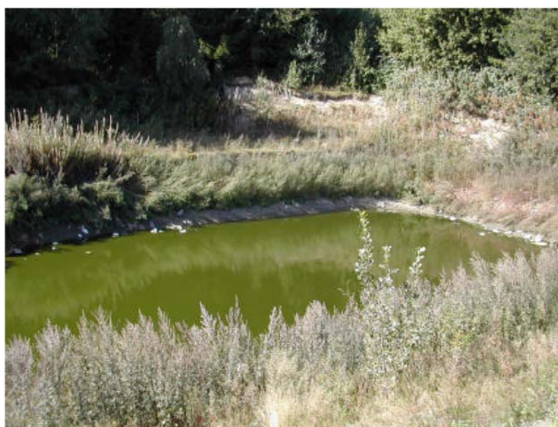
Figur 33. Infiltrasjonsbasseng etter aktivt slam og sedimentering (foto BB)
