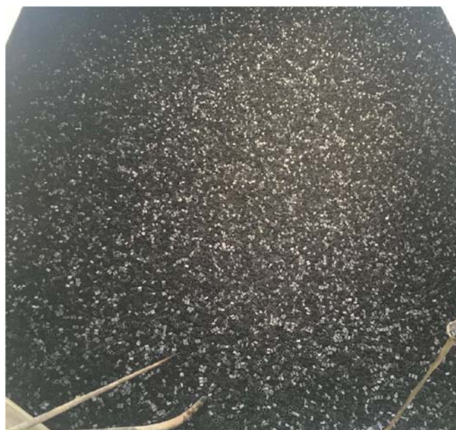
Figur 22. Bilde fra basseng fylt med bæremateriale i MBBR (foto ROAF)
